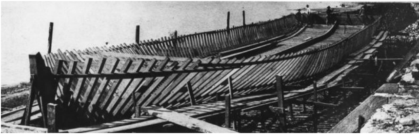
Knox and sons boatyard ca. 1875, zu sehen ist das Spantgerippe eines Neubaues.
